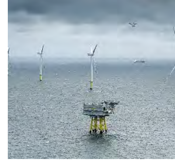
Tuulivoimalat ja sähköasemat
